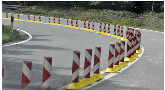
Fahrbahnteiler mit Leitschwellen und Leitbaken (Zeichen 605).
